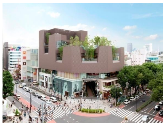
東急プラザ 表参道原宿 外観
